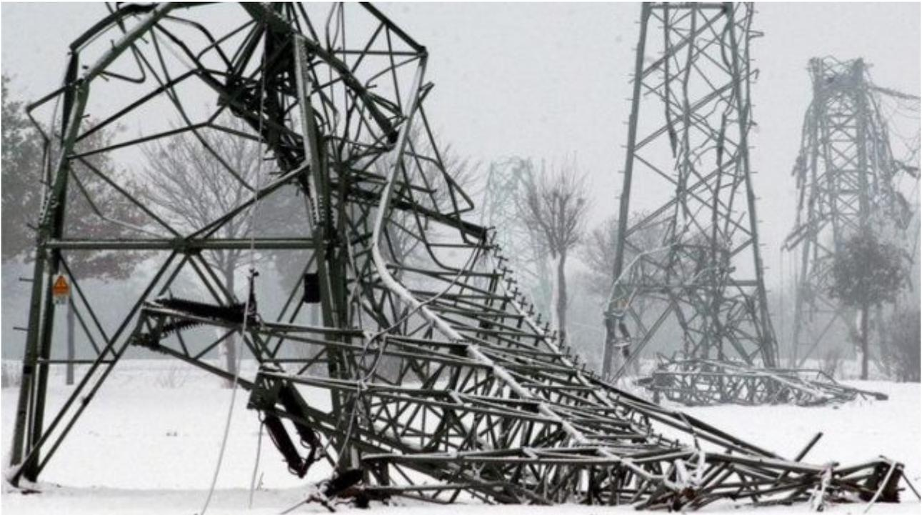
Bild 6: Typisches Schadensbild an den vom Eis überlasteten Hochspannungsmasten im Münsterland 2005 (Quelle. WDR)
